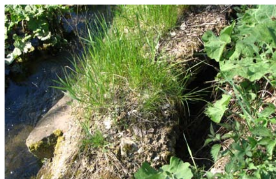
Abb. 78: Verfallende Betonsicherung (Foto: S. Merx)
