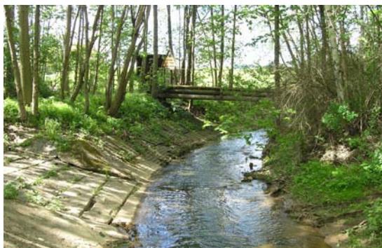
Abb. 79: Naturferne Uferbefestigung in der Sprotte (Foto: M. Schmidt)
