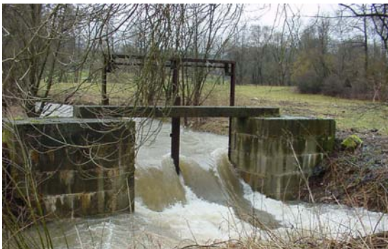
Abb. 53: Ehemaliges Bewässerungswehr in der Effelder (Foto: J. Görlach)
