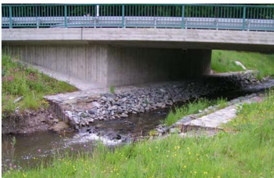
Abb. 65: Sohlleiste an einer Brücke mit negativer Auswirkung auf die Durchgängigkeit (Foto: M. Dittrich)
