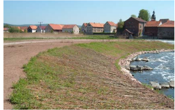
Abb. 72: Einbau von Weidenspreitlagen als zusätzliche Böschungssicherung (Foto: J. Görlach)
