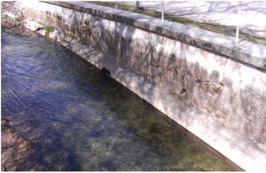
Abb. 67: Am Prallufer stark unterspülte Ufermauer der Bode im urbanen Umfeld (Foto: H. Thiernt)
