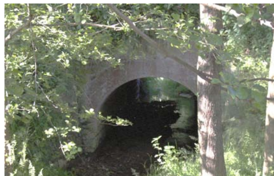
Abb. 66: Sedimentablagerungen innerhalb eines Durchlasses mit positiver Auswirkung auf die Durchgängigkeit (Foto: H. Thiemt)
