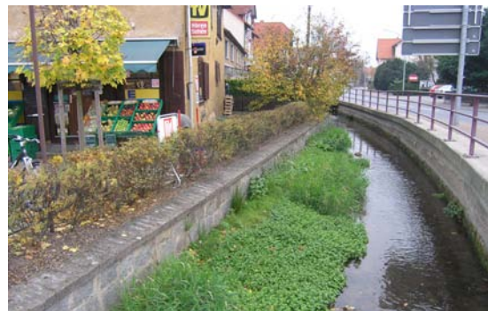
Abb. 29: Röhrichtaufwuchs über Sedimentanlandung im besiedelten Bereich (Foto: M. Schmidt)
