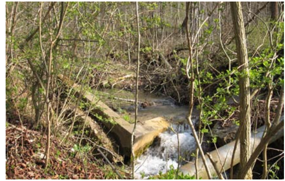
Abb. 56: Zugelassener Verfall eines alten Wehres (Foto: H. Thiemt)
