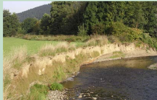
Abb. 104: Uferabbrüche nach mehreren Hochwasserabflüssen (Foto: U. Koenzen)
