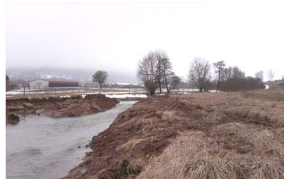
Abb. 74: Am gegenüberliegenden Gleitufer neu trassierte Rinne für den Mittelwasserabfluss der Bode (Foto: H. Thiemt)
