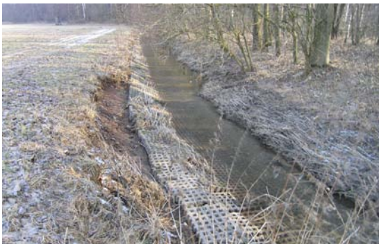
Abb. 43: Naturferne Sohlenbefestigungen in der Sprotte in Posterstein (Foto: M. Schmidt)
