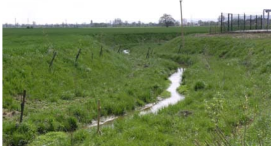
Abb. 97: Bauliche Anlage einer Sekundäraue innerhalb intensiv genutzter landwirtschaftlicher Flächen durch Profilaufweitung auf Mittelwasserniveau (Foto: U. Koenzen)
