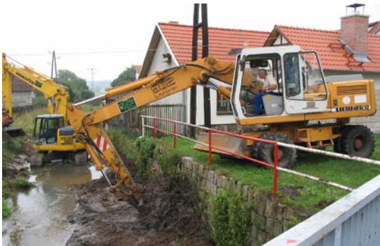
Abb. 28: Räumung eines Gewässers im besiedelten Bereich (Foto: S. Merx)
