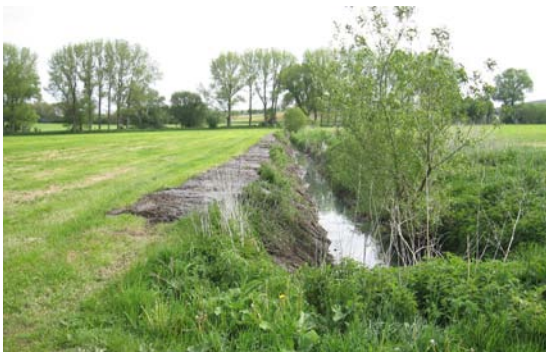
Abb. 30: Graben Wolframshausen nach Sohlräumung (Foto: H. Thiemt)
