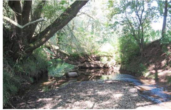
Abb. 51: Akzeptabler Verbleib von Abflusshindernissen (Sturzbaum und Kiesbank) in der Bode (Foto: H. Thiermt)
