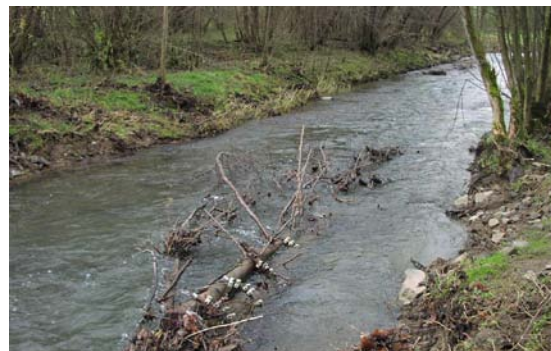
Abb. 39: Sohlensicherung durch Totholzeinbau (Foto: A. Kurth)
