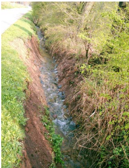
Abb. 38: Sohlensicherung mit gewässertypischem Material in einem Karstbach (Foto: H. Thiemt)
