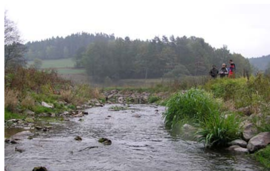
Abb. 54: Flache und biologisch durchgängige raue Rampe nach dem Umbau des ehemaligen Wehrs in der Effelder (Foto: J. Görlach)
