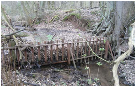
Abb. 60: Schrittweises Anheben der Sohle durch Sohlrechen als Grundlage für die Ansammlung von Totholz und Sedimenten (Foto: M. Schmidt)
