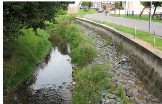
Abb. 68: Vergleichsfoto zu Abb. 67: Sanierter Zustand nach der Durchführung von Sicherungsmaßnahmen (Foto: H. Thiernt)
