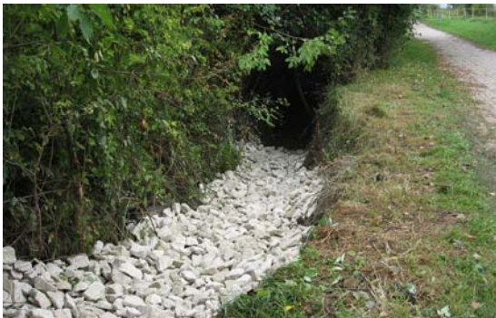
Abb. 38: Sohlensicherung mit gewässertypischem Material in einem Karstbach (Foto: H. Thiemt)
