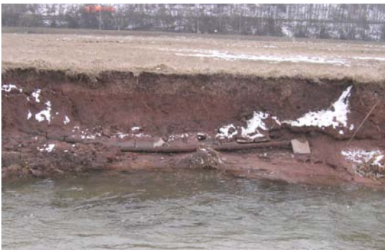
Abb. 73: Durch eigendynamische Entwicklung entstandener Uferabbruch an der Bode (Foto: H. Thiemt)
