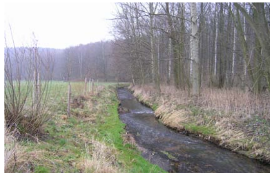
Abb. 44: Vergleichsfoto zu Abb. 43 nach Entnahme der Sohlenbefestigungen (Foto: M. Schmidt)
