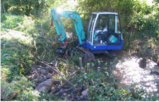
Abb. 71: Einbau eines Raubaums zur Ufersicherung (Foto: S. Merx)
